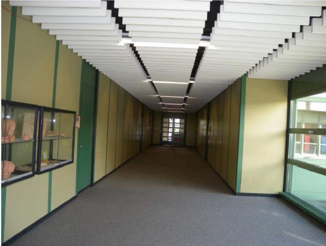
Bild 1 typische flurseitige Ansicht der Mechel-Systemwände und der Lamellendecke in der RWS-FOS-BOS Augsburg
