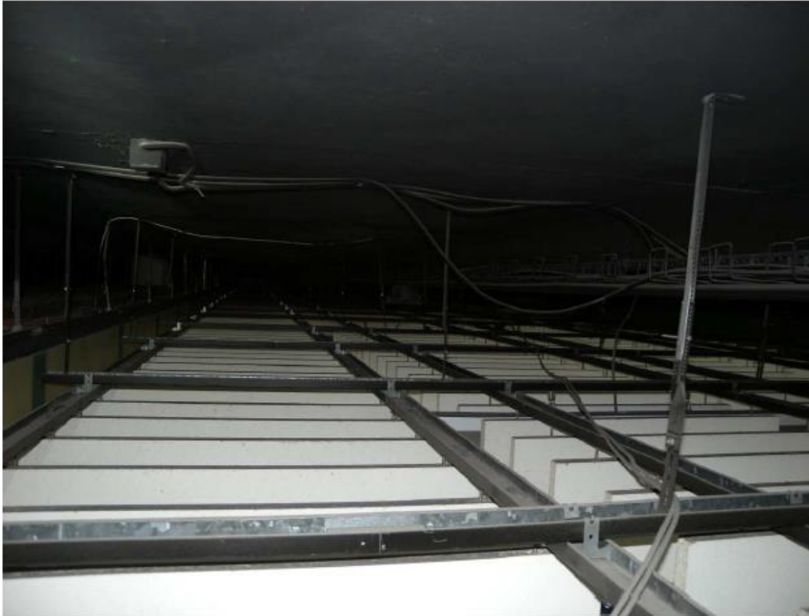
Bild 5 Ansicht der flurseitigen Lamellenunterdecke von der Oberseite
