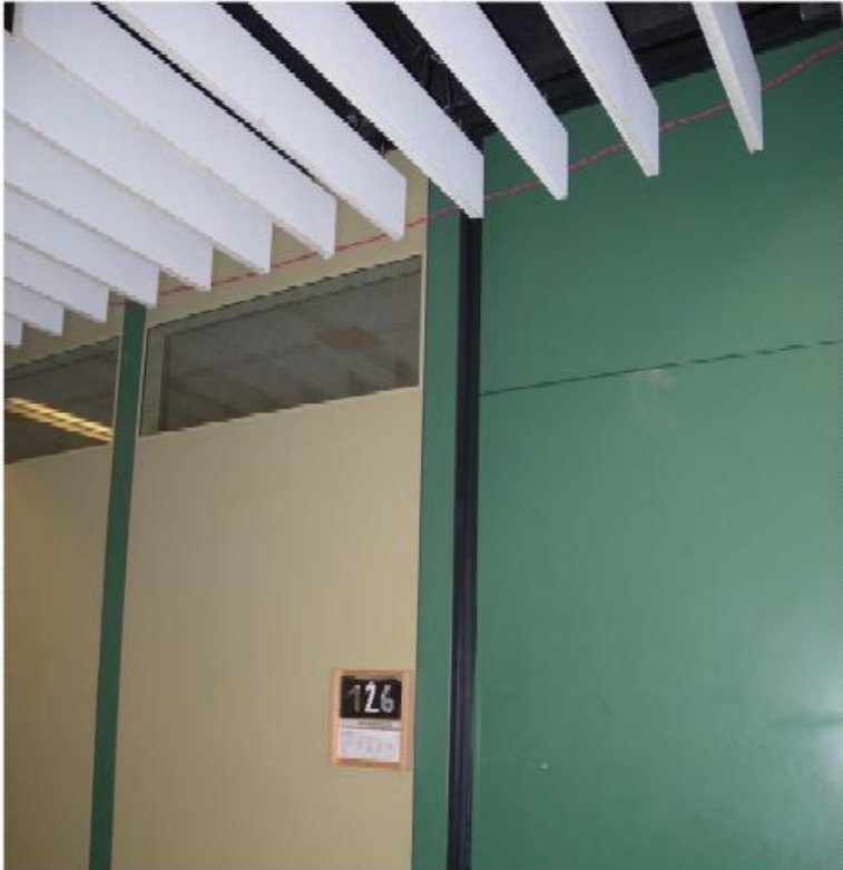
Bild 7 Mechel-Systemwand M 123-421 mit Oberlicht (rechts bemaßtes Wandelement mit angrenzendem 100 mm breitem Bandraster)
