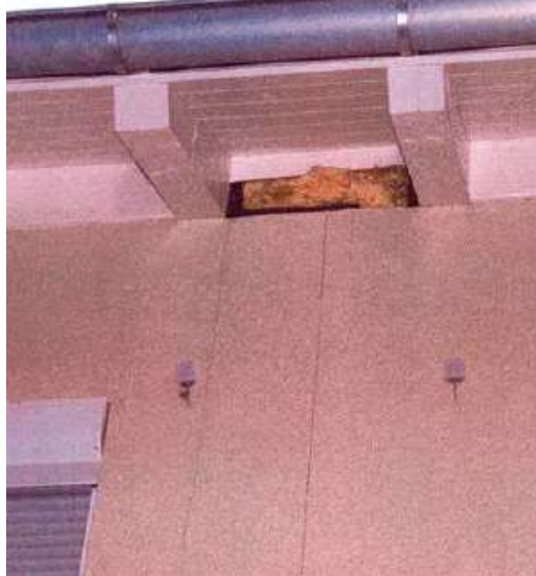
Bild 11 Am Sparren ablaufendes Wasser
